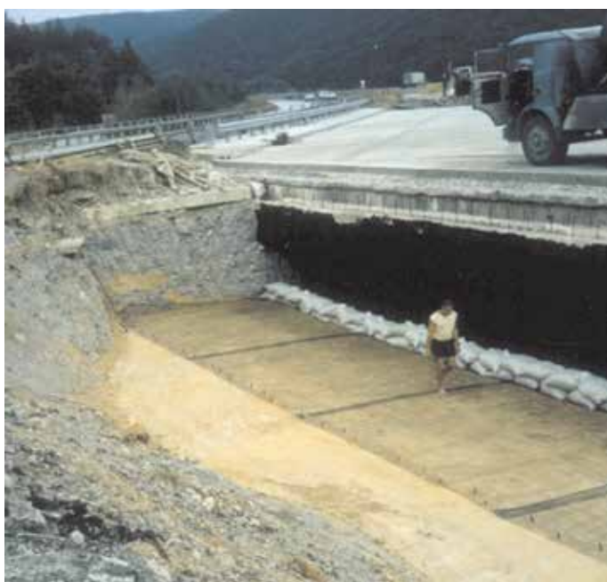
Rys. 6. Instalacja zbrojenia za ścianą przyczółka, lico z worków wypełnionych piaskiem [4]
