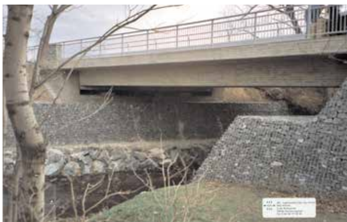
Rys. 10. Widok mostu na rzece Ilse w Niemczech [5]
