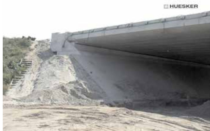
Rys. 13. Widok wiaduktu w końcowej fazie prac budowlanych na drodze N 242 w Holandii [12]
