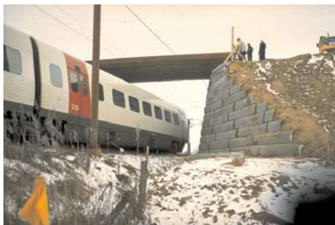
Rys. 8. Widok przyczółka w budowie w miejscowości Ullerslev w Danii, 1991 [1]
