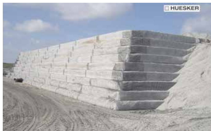
Rys. 12. Przyczołek z gruntu zbrojonego na drodze N242 w Holandii przed wylaniem belki fundamentowej [12]
