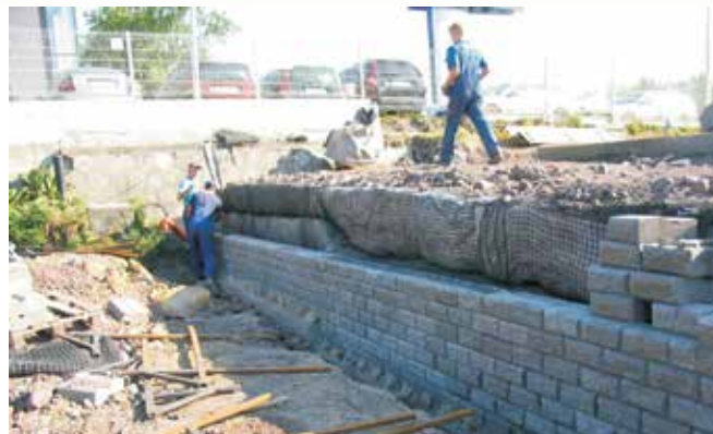
Fot. 1. Wznoszenie samostatecznej ściany biernej
