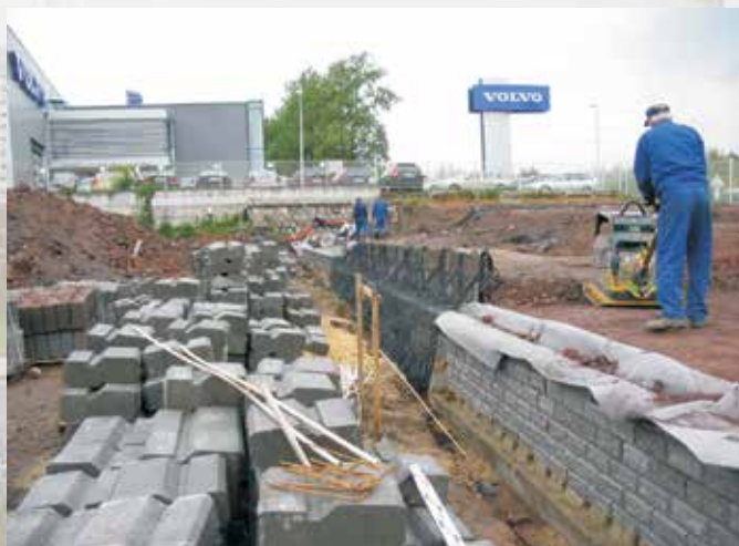
Fot. 1. Budowa bloku z gruntu zbrojonego z zastosowaniem szalunków przestawnych
