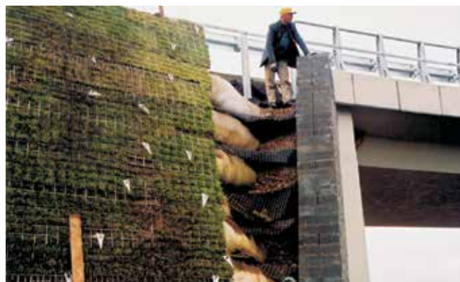
Fot. 3. Wznoszenie wraz z kotwieniem ściany oporowej
