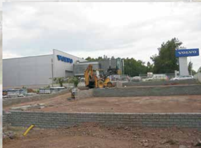
Fot. 2. Wykonane trzy poziomy parkingów wystawowych
